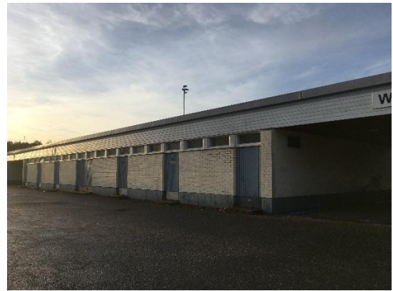
Kuva 5.38, Julkisivua itään, rakennusosa B
