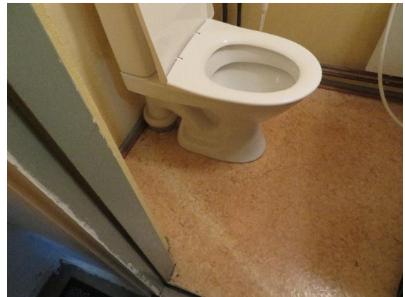
Kuva 5.8, Alkuperäiskuntoinen wc, rakennusosa D
