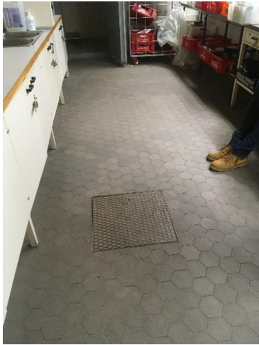
Kuva 5.19, Kioskitilan alkuperäinen lattia, kan- nen kohdalla putkikanava, rakennusosa A
