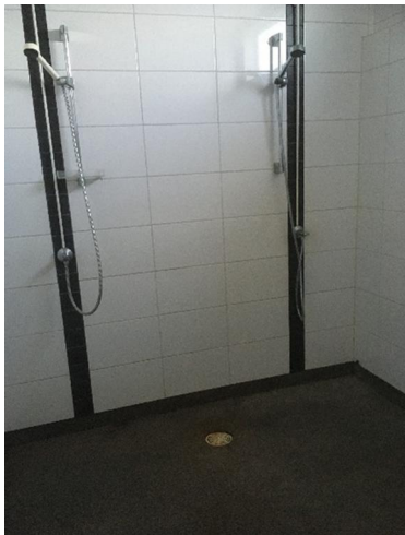
Kuva 5.29, Pesuhuone, entinen asuntotila, rakennusosa A
