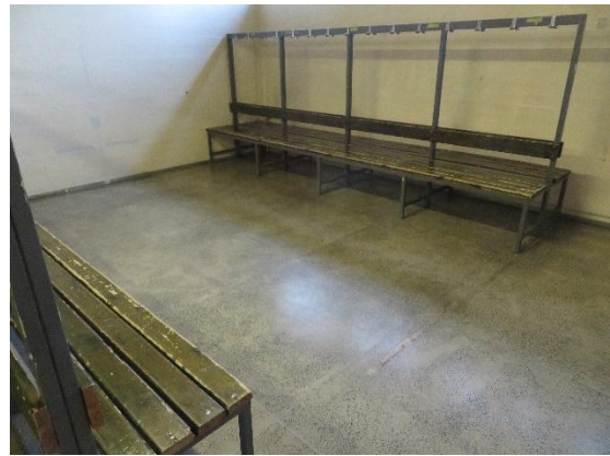
Kuva 5.14, Alkuperäiskuntoinen pukuhuone, rakennusosa B
