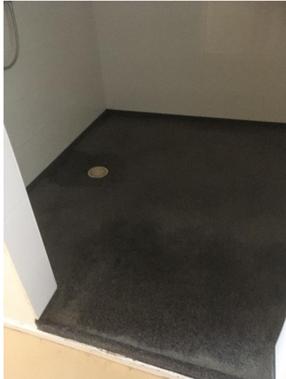
Kuva 5.27, Varasto/pesutilaa, entinen talouskellari, rakennusosa A
