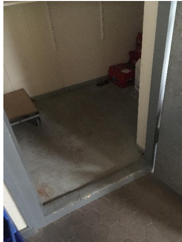
Kuva 5.20, Jäähdytys huone, rakennusosa A
