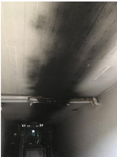
Kuva 5.23, Traktoritilan kattoa ja putkiraken- teita, rakennusosa A
