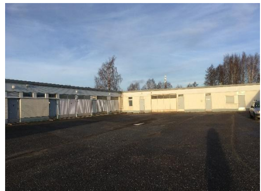
Kuva 5.36, Itäjulkisivu rakennusosa D, eteläjulkisivu rakennusosa E
