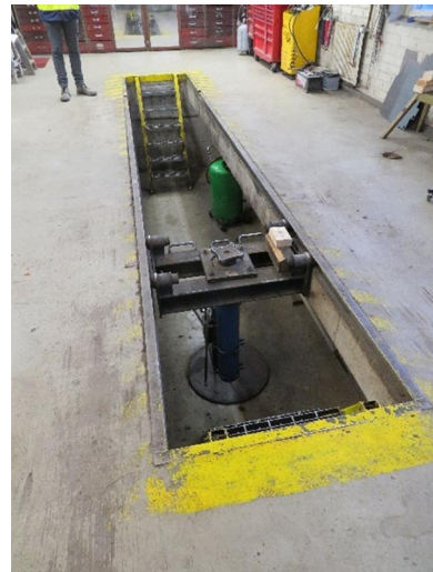
Kuva 5.4, Rasvamonttu rakennusosa D:n työtilassa
