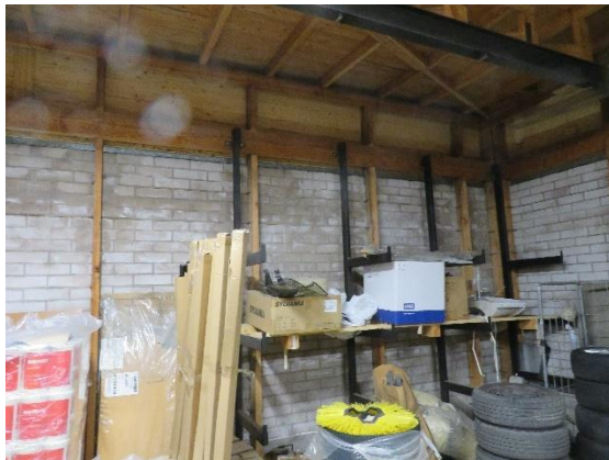
Kuva 5.3, Kylmän varastotilan rakenteita, rakennusosa E
