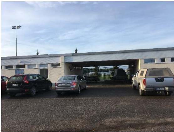
Kuva 5.37, Katettu osa rakennusosien C ja D välissä, julkisivu itään
