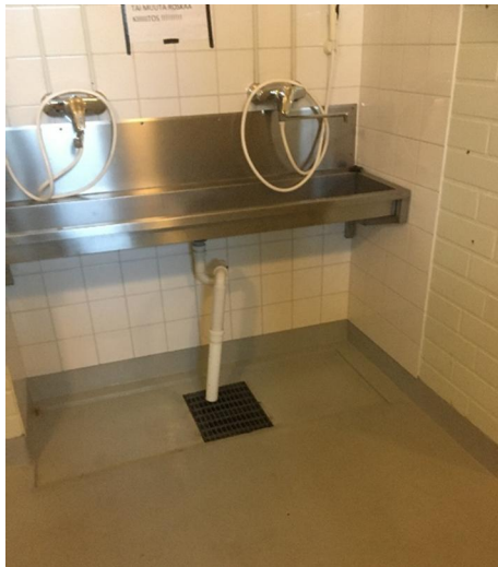
Kuva 5.39, Pääkatsomon alapuolisen tilan pesuhuonetta
