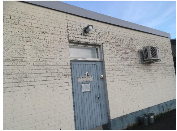
Kuva 5.32, Eteläpään julkisivu, rakennusosa A
