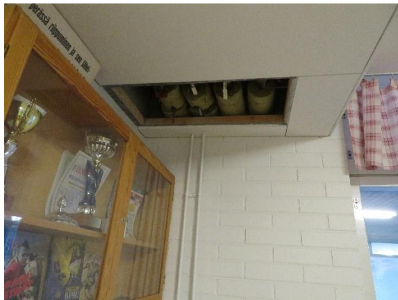
Kuva 5.7, Ruokailutilan katon alaslasku, putki-reitti, rakennusosa D
