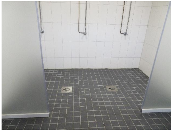
Kuva 5.13, Remontoitu pesuhuone, rakennusosa B
