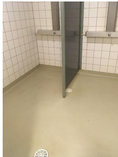
Kuva 5.24, Pesuhuonetilaa entisen kattila- huoneen kohdalla, rakennusosa A
