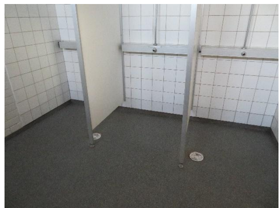
Kuva 5.6, Remontoitua pesutilaa, rakennusosa D
