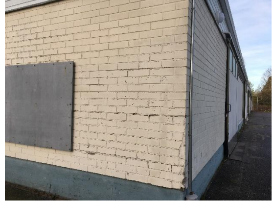
Kuva 5.34, Etelä – itäjulkisivun nurkkaus, rakennusosa E
