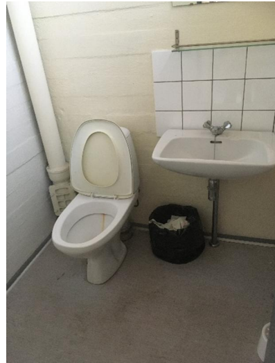
Kuva 5.22, Alkuperäiskuntoinen wc, raken- nusosa A
