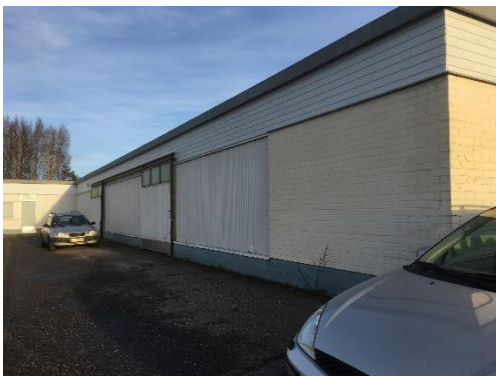
Kuva 5.35, Länsijulkisivua, rakennusosa E
